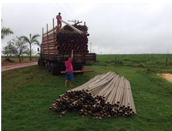
Entrega do Material da rede de distribuição de água
