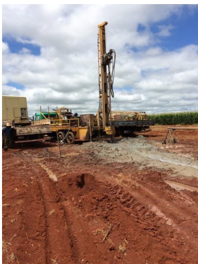
Perfuração do poço
