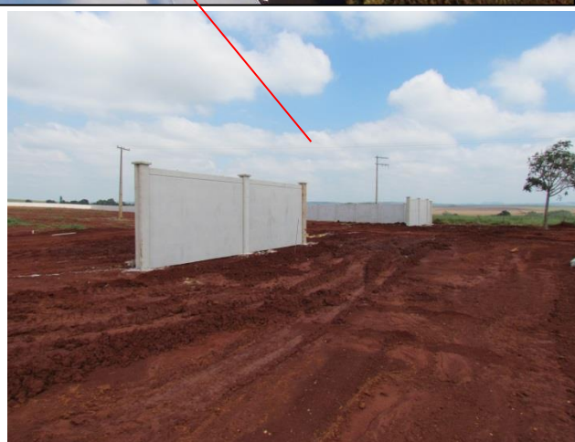
Vão entre dois trechos de muro para construção da portaria
