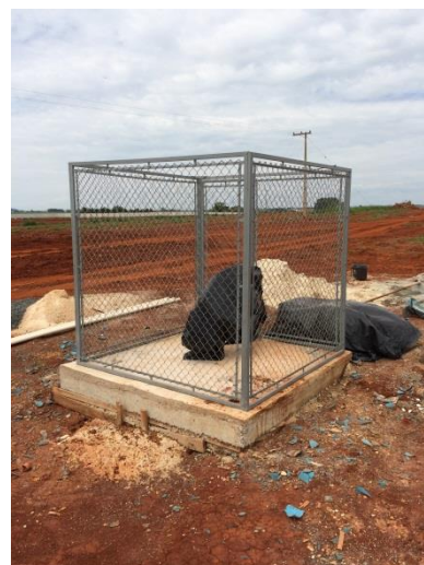
Montagem da gaiola
