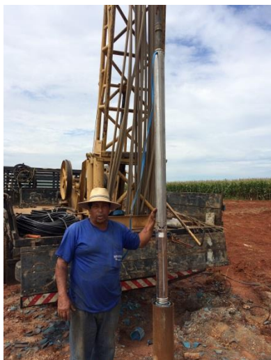
Instalação da bomba submersa
